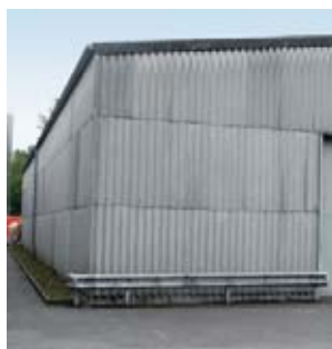
1 Facciata rivestita di lastre contenenti amianto
