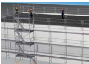
1 Tetto piano con ponte da lattoniere
