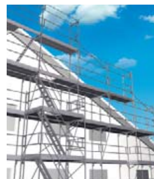
3 Accesso al tetto spiovente tramite un ponteggio dotato di corpo scala
